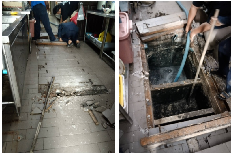
ภาพที่ 4-32 ดูตะกอนไขมันที่ปอดักไขมัน
