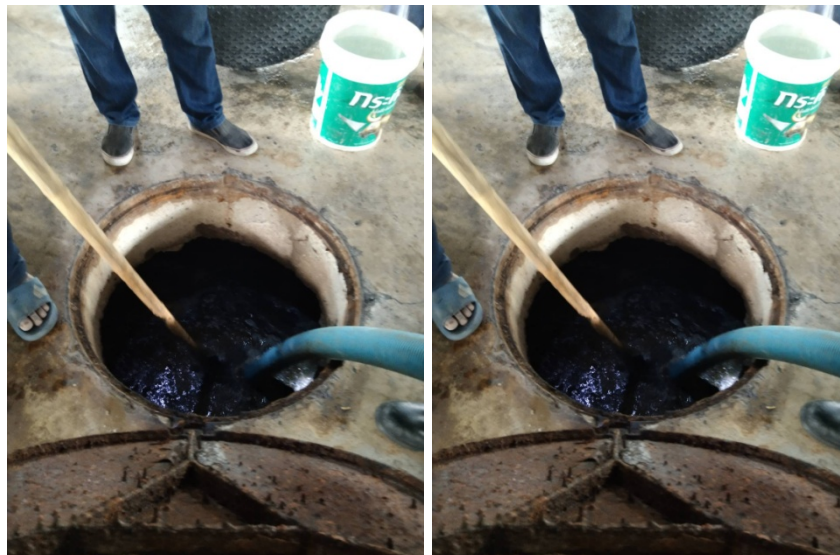
ภาพที่ 4-32 ดูตะกอนไขมันที่ปอดักไขมัน
